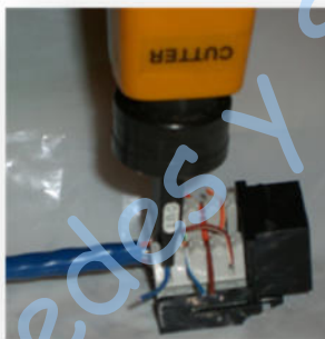
Figura No. 3. Uso de las pinzas de impacto
